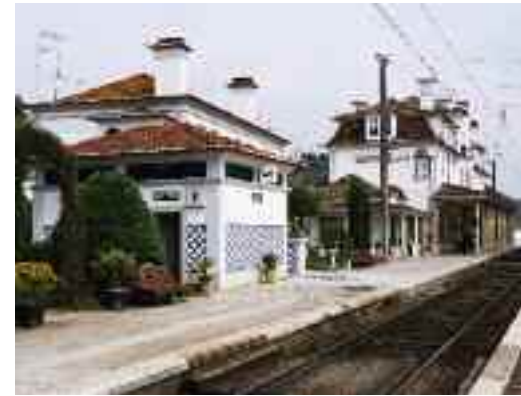
ESTAÇÃO DE SANTARÉM
