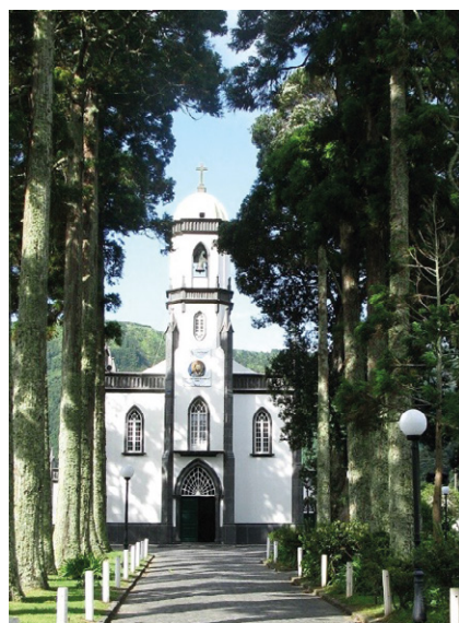
Aspeto geral do acesso à Igreja de S. Nicolau
